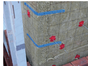
zum Stabilisieren der Kerndämmung an den Ecken
